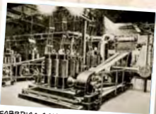
FABBRICA CON IMPIANTO ELETTRICO
