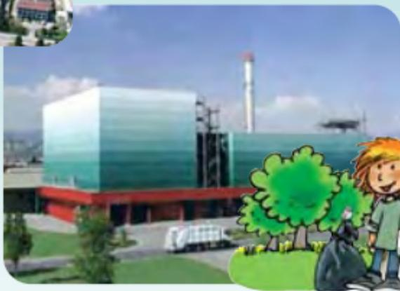
preziosa fonte di energia per la città di Bergamo; grazie al funzionamento dell'impianto è possibile infatti produrre non solo energia elettrica ma anche recuperare energia termica, convogliando il calore prodotto dalla combustione dei rifiuti nella rete del teleriscaldamento, fino alle abitazioni dei singoli cittadini.
